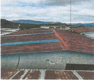
FOTO 1. SUSTITUCIÓN DE TECHO DE LÁMINA, MODULO 1
